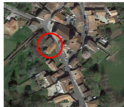
Localisation parcelle AS390 – Vue aérienne
