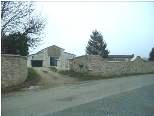
Fronton : ancien bâti, parcelle 58
