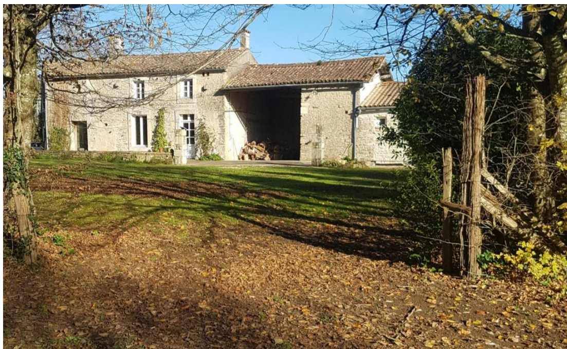
Figure 15 : Bâtisse existante, source : Propriétaires de bâtisse
